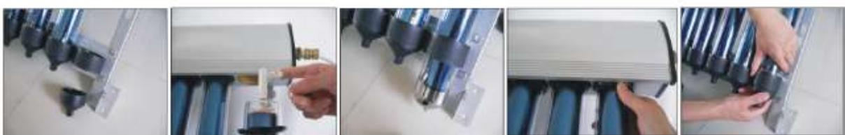
**Шаг 1:** прежде всего, разместите фиксатор трубы на нижней направляющей, затем выверните наконечник нейлонового колпачка (конструкция нижнего фиксатора трубы может отличаться от описанной).
