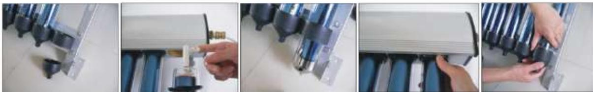
**Шаг 1:** прежде всего, разместите фиксатор трубки на нижней направляющей, затем выверните наконечник нейлонового колпачка (конструкция нижнего фиксатора трубки может отличаться от описанной).
