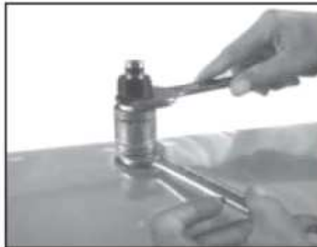
Использование ключей для фиксации ниппеля перед затягиваем труб
